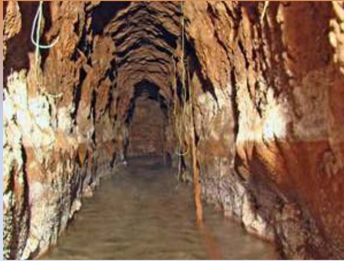
داخل یک گالری زهکشی افقی بزرگ
